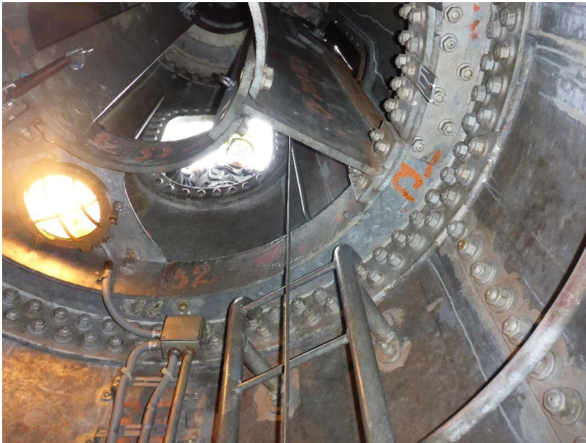
Bild 10: Die Lukenöffnung beträgt 700 mm x 500 mm:
