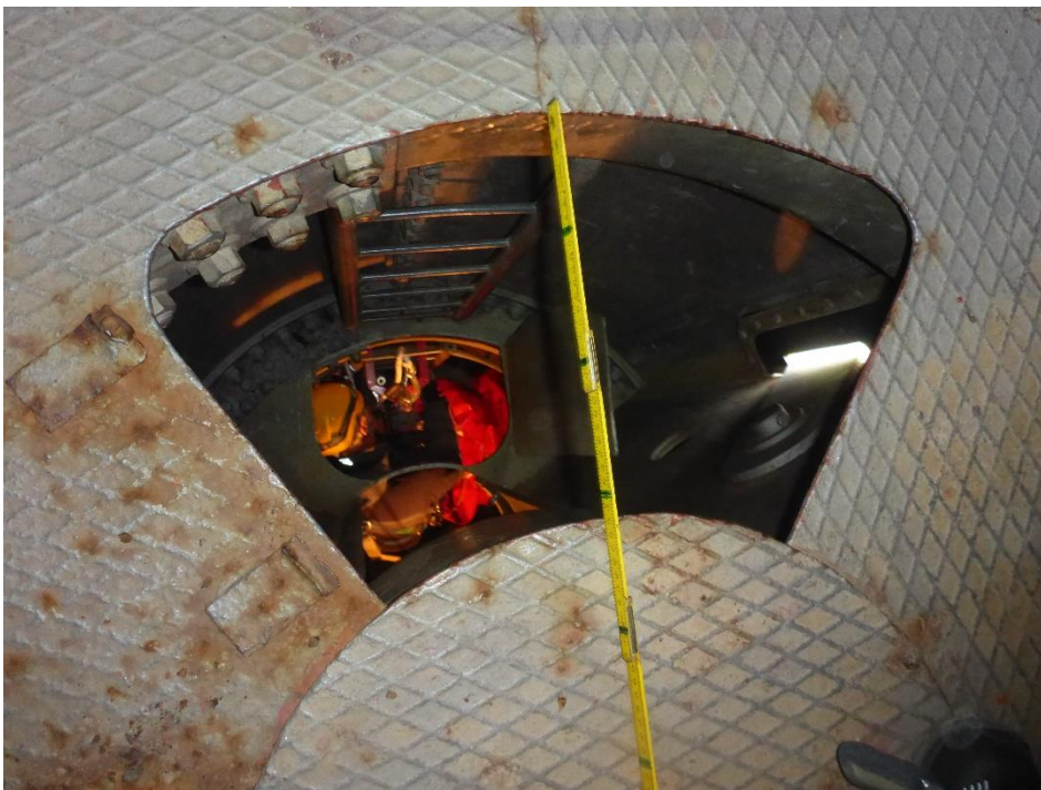
Bild 7: Durchstieg an der 1. Pardunenscheibe von oben (Tiefe 310 mm)
