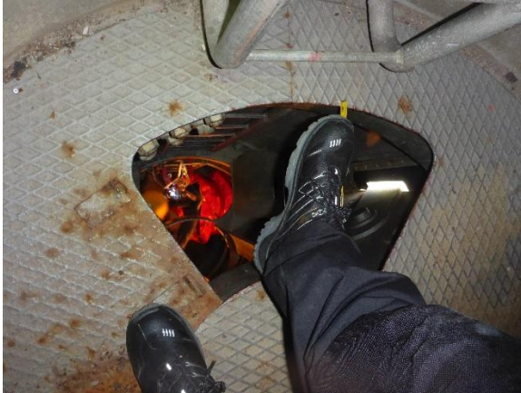
Bild 8: Durchstieg an der 1. Pardunenscheibe von oben
