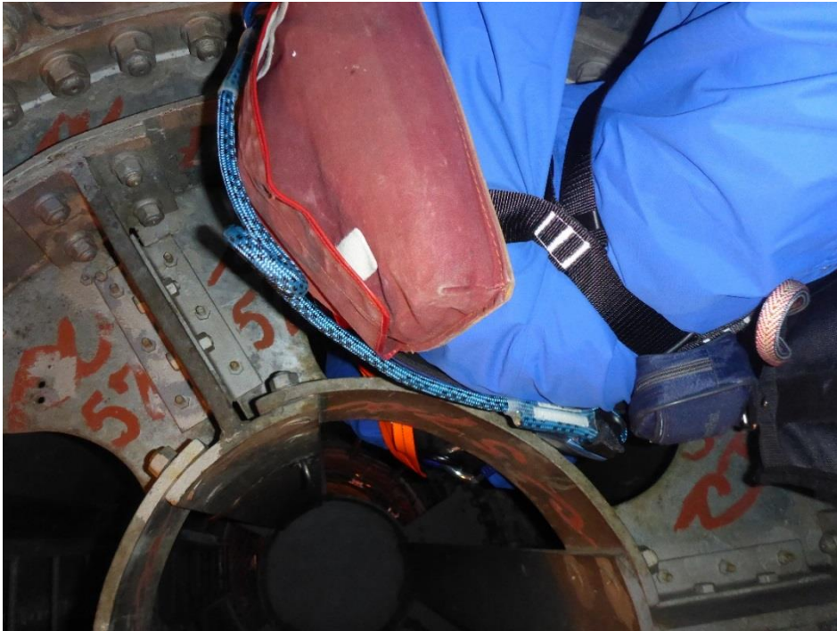
Bild 6: Durchstieg an der 1. Pardunenscheibe von unten
