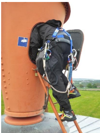
Bild 5 – Einstieg am Mastfuß
