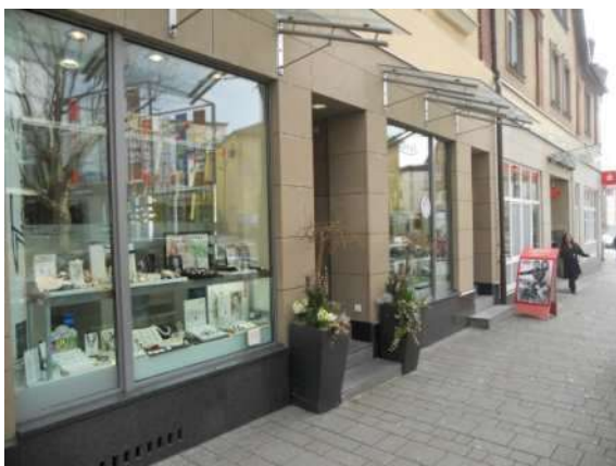
Foto 3: Bahnhofstraße: sanierte Fassade
