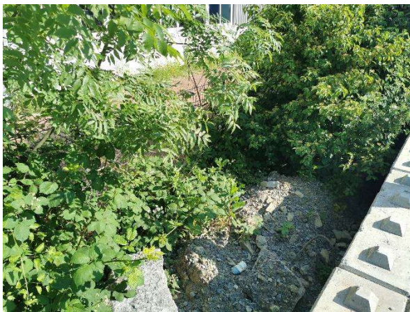
Abb. 4: Schotter und Bauschutt
