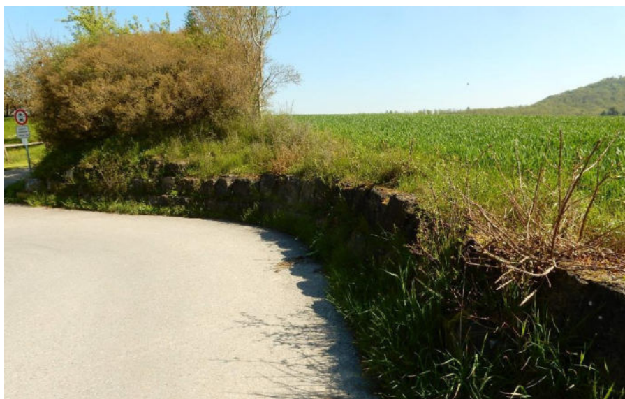
Foto 2: Südlicher Teil der Feld- hecke mit vorgelagerter Trockenmauer aus Blocksteinen, Foto April 2020
