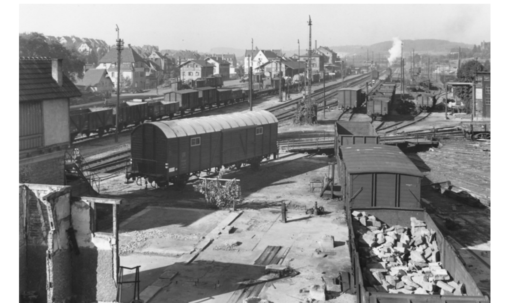
➤ Ehemalige württembergische Drehscheibe und Lokschuppen mit Kriegszerstörungen, links Stellwerk. (Landesbildstelle Württemberg 1949, Vorlage: Stadtarchiv Mühlacker)
