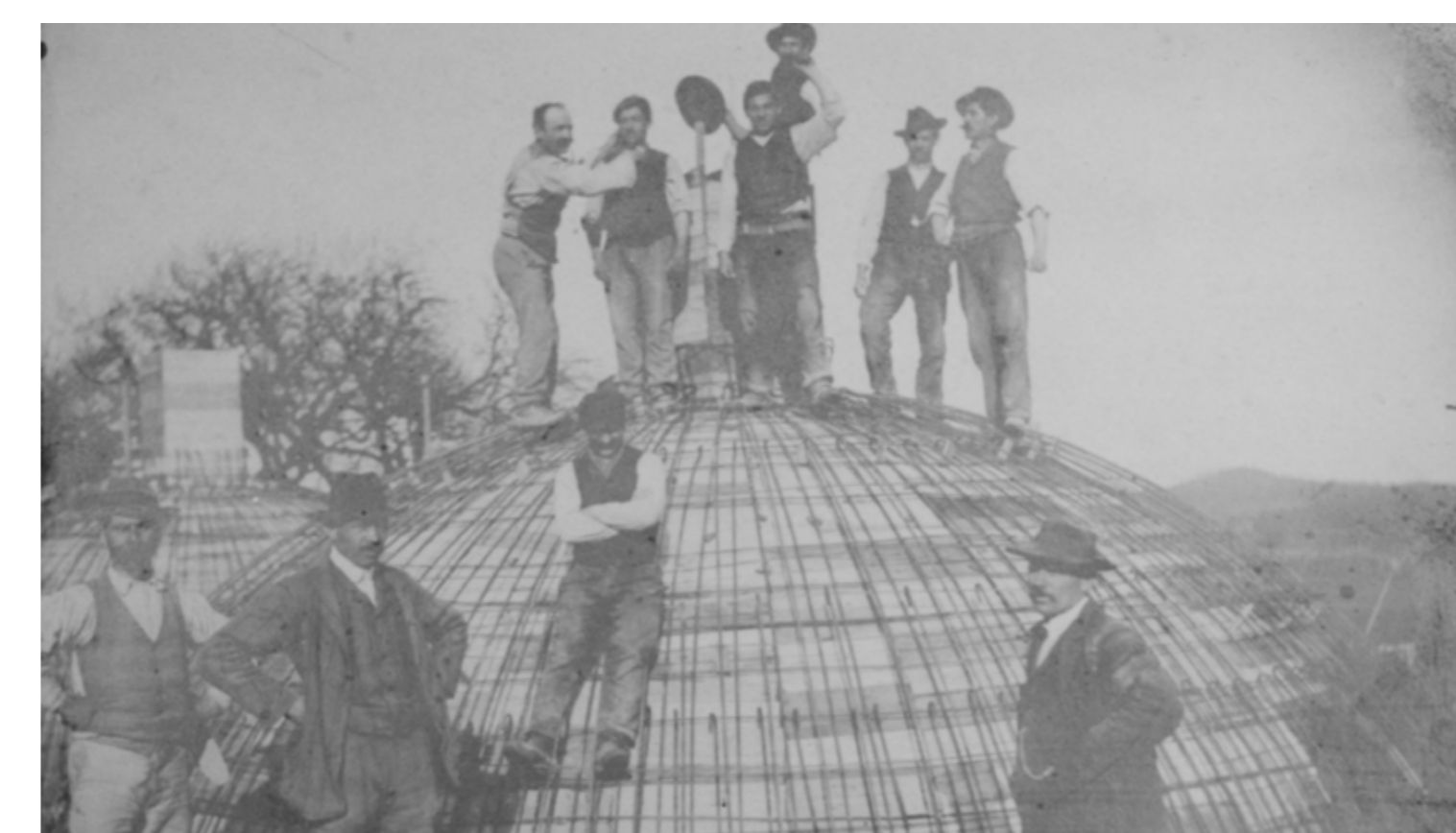
➤ Bau des Wasserhochbehälters Ulmer Schanz 1909-1911 mit einem Fassungsvermögen von 256 m³. (Stadtarchiv Mühlacker)
