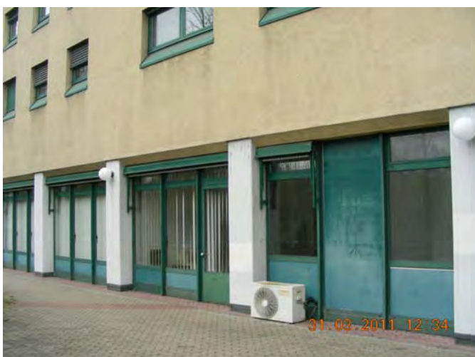
Fassadenansicht Gewerbe Ostseite
