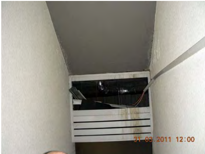
Undichte Stelle an Eingangstüre unter Treppenhaus beim FA
