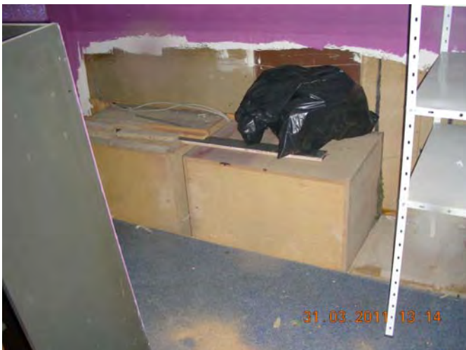
dahinter sind vermutlich Lüftungskanäle
