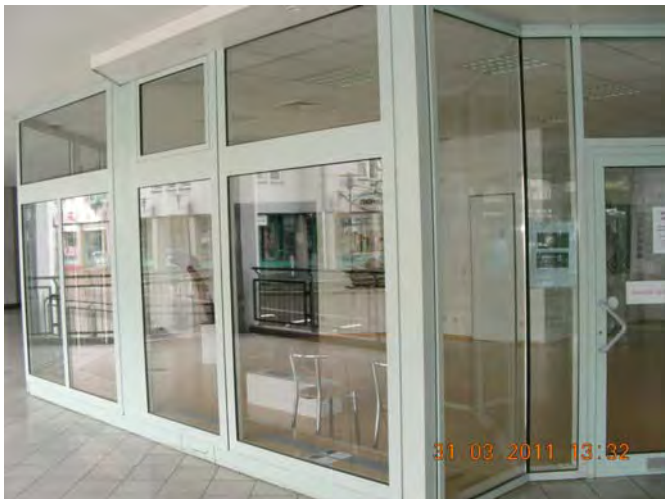
Läden leerstehend auf Nordseite
