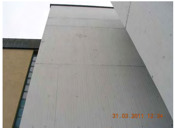
Sichtbeton ungedämmt
