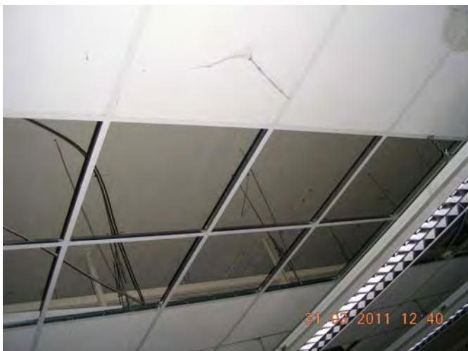
Deckenteile demontiert
