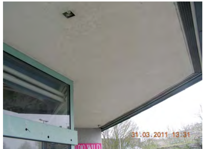
Decke Arkadenbereich Nordseite
