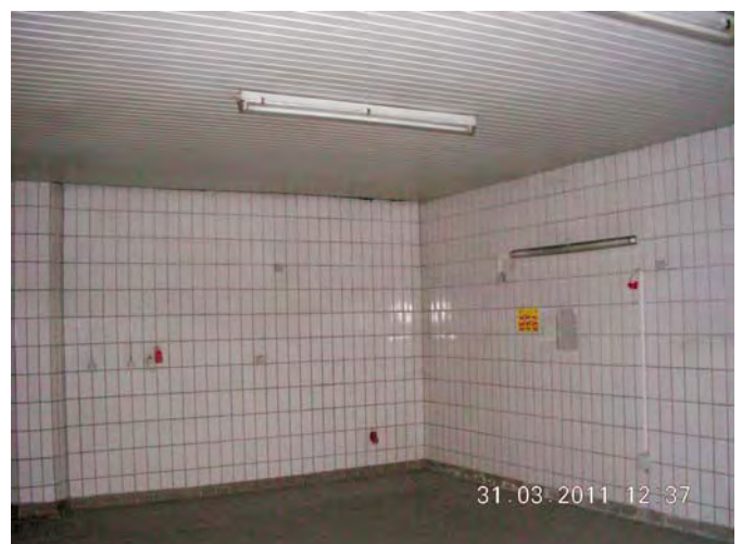
Ehemaliger Kühlraum / Fleischanlieferung Basement
