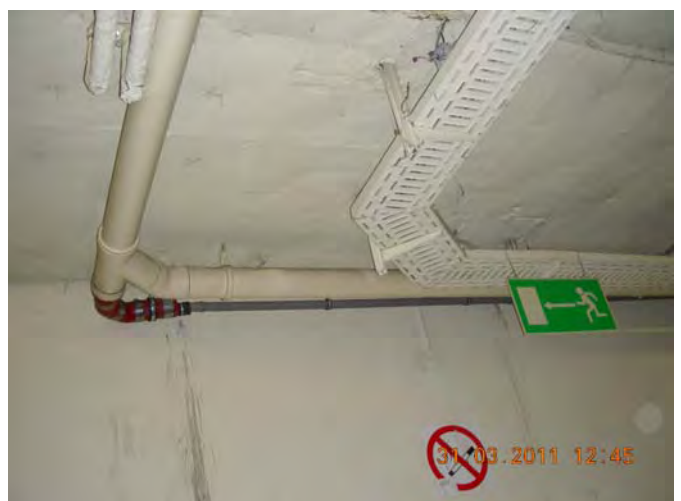
Leitungen unter Decke
