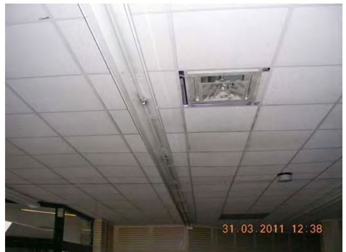
OWA-Decken Laden Basement
