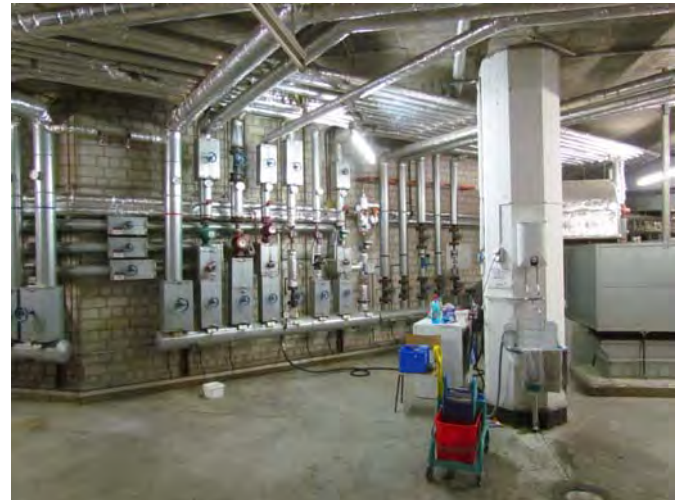
Heizungsverteiler Lüftungszentrale
