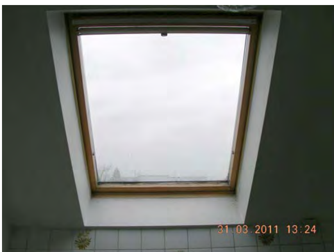
Dachfenster leerstehende Wohnung
