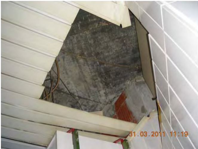
Decke Küchenbereich teilweise demontiert
