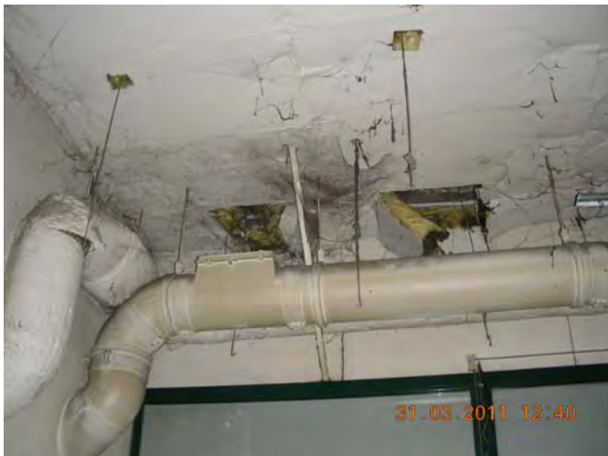
Leitungen unter der Decke
