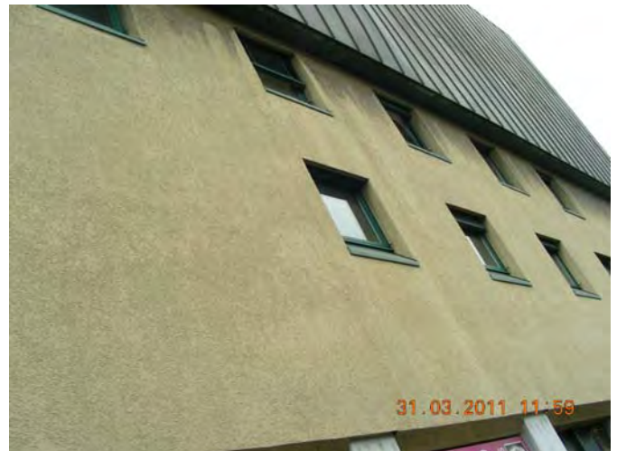
Putzfassade / Blechverkleidung Südwestfassade
