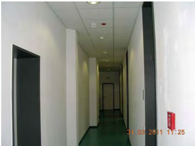
Umgebauter Bereich Finanzamt
