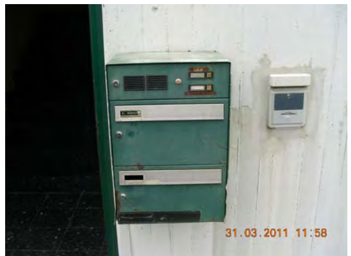
Briefkasten am Treppenhaus Südwest
