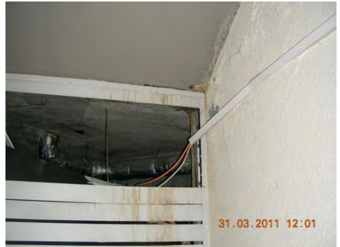
Undichte Stelle unter Treppenhaus beim FA
