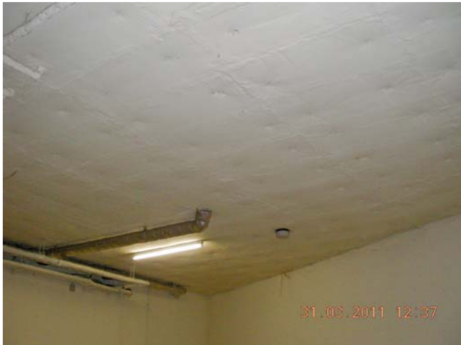
Decken - minimal gedämmt
