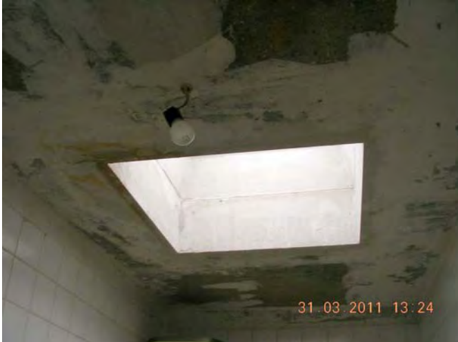
Bad leerstehende Wohnung
