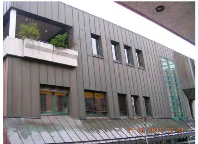
Blechverkleidung - leichte Dellen
