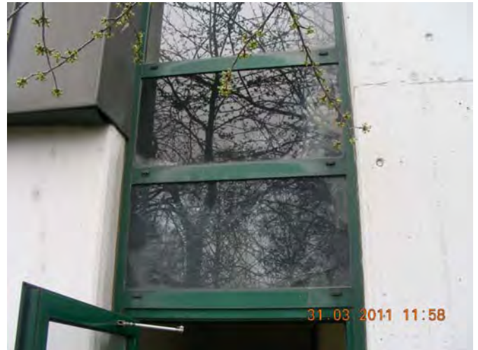
Fenster Treppenhaus FA - Südwestseite
