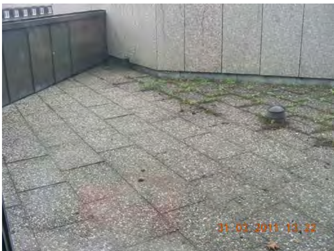
Dachterrassen vor Wohnungen im 3.OG
