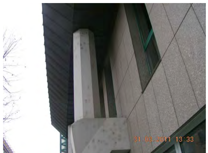
Aussenstützen ungedämmt
