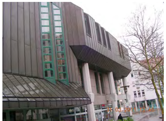
Kupferverkleidung / Fassade Blickrichtung Norden
