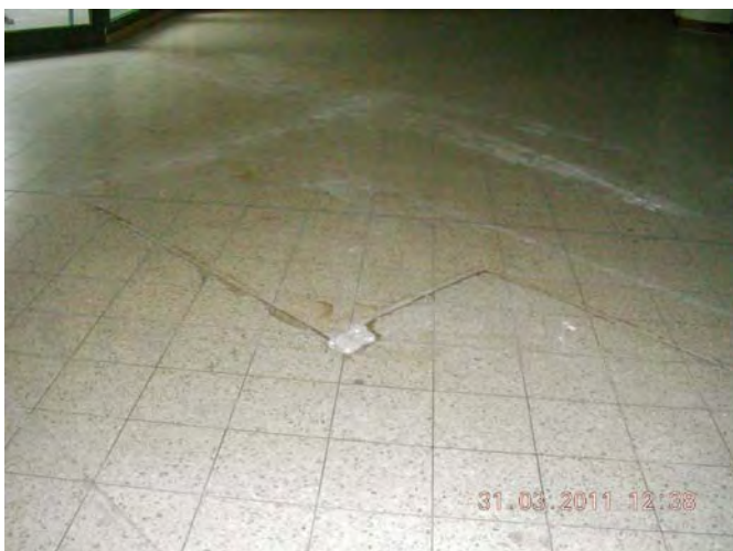
Bodenbeläge Laden Basement
