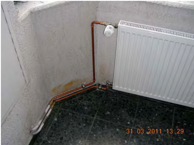
HK Flur - Rohre repariert
