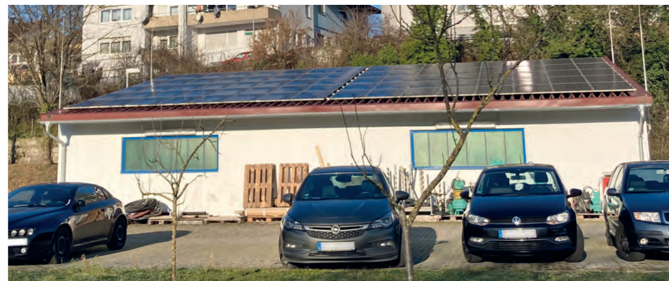
PV-Anlage des Eigenbetriebs Stadtentwässerung
