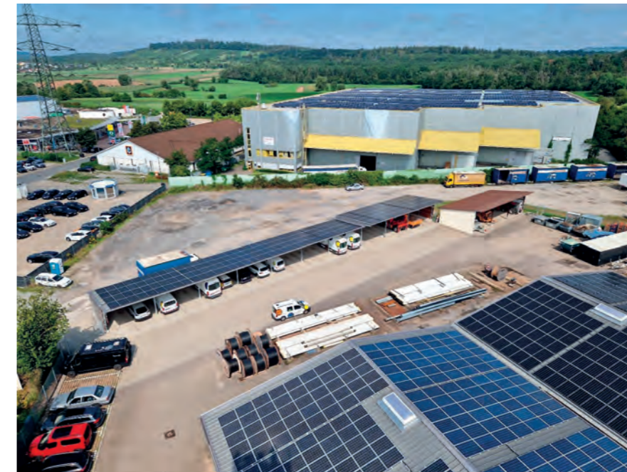
PV-Anlage auf Gebäuden der Stadtwerke Mühlacker
